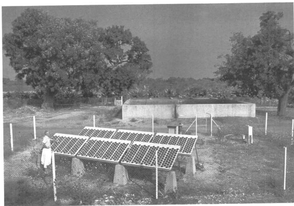
Motore solare di 900 W a Koni (Mali) (foto di Ferorelli).
